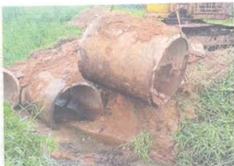
Kerja mengorek pembetung yang menjadi penghalang laluan air dilakukan.
