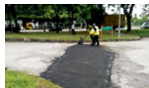
Kerja-kerja tampalan Jalan Astaka L U8/L dilaksanakan oleh petugas 'Road Gang'
