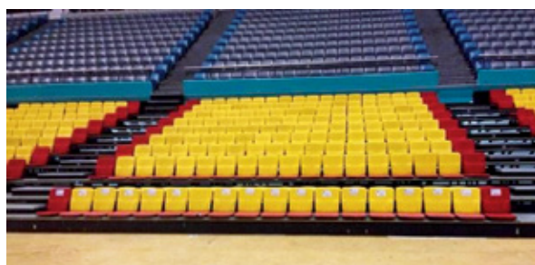
Gambar kerja-kerja pembaikan
