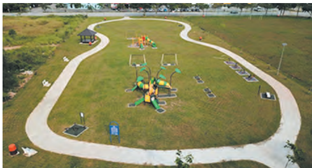
Kerja-Kerja Membina Dan Menyiapkan Taman Awam Di Jalan Sungai Rasau 32/23, Seksyen 32, Shah Alam
