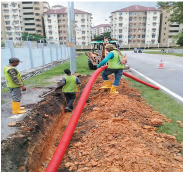
Kerja-kerja penggantian kabel
