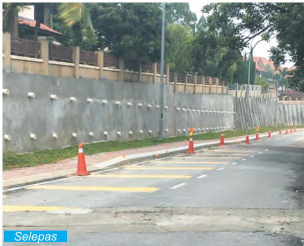
Kerja-Kerja Pembaikan Tembok Penahan Di Jalan Mimbar U8/2, Seksyen U8, Shah Alam
