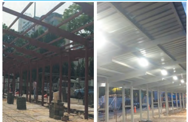
Kerja-kerja pemasangan lampu solar di kawasan Wisma MBSA
