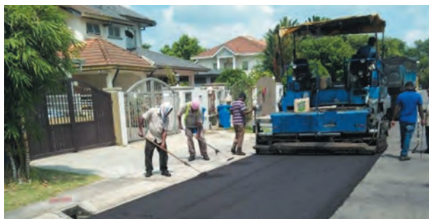
Kerja-kerja turapan jalan.
