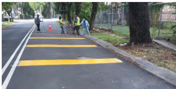
Kerja-kerja turapan dan road marking jalan.
