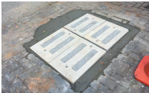
Kerja-kerja membaikpulih dan penggantian penutup longkang.
