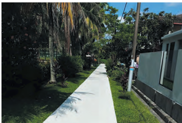
Pembinaan laluan pejalan kaki (Fasa 2) dengan kemasan concrete broom finish merangkumi keseluruhan taman permainan dan tasik di Taman Rekreasi Bandar Baru Sungai Buloh sepanjang 783mr dengan saiz kelebaran 1.8 meter hingga 3.0 meter
