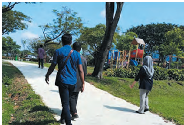
Pembinaan laluan pejalan kaki (Fasa 2) dengan kemasan concrete broom finish merangkumi keseluruhan taman permainan dan tasik di Taman Rekreasi Bandar Baru Sungai Buloh sepanjang 783mr dengan saiz kelebaran 1.8 meter hingga 3.0 meter
