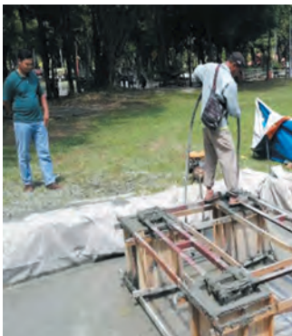
Kerja-kerja pembinaan tapak untuk e-billboard
