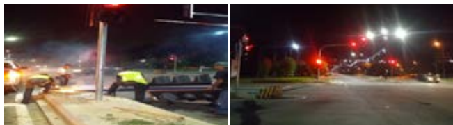
Kerja-Kerja Pemasangan Kabel Bawah Tanah Untuk Lampu Isyarat Sedang Dilaksanakan
