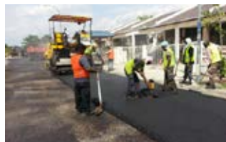
"Wearing Cost-AC14" Menggunakan "Asphalt Paver"
