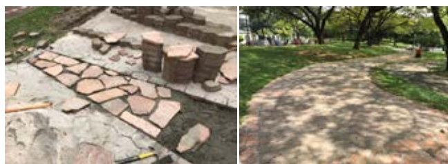
Kerja-kerja Penambahbaikan Laluan Pejalan Kaki dan Fasiliti di Taman Tasik Shah Alam
