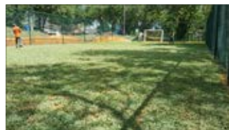
Kerja-kerja membina Gelanggang Futsal Berumput
