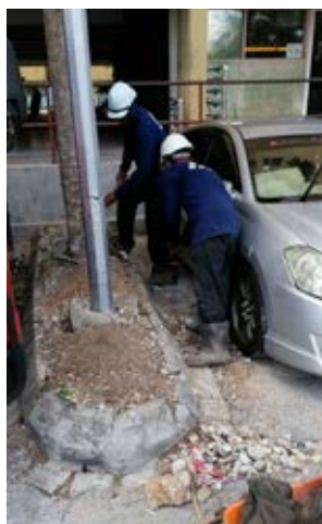
Kerja-kerja pemasangan tiang lampu
