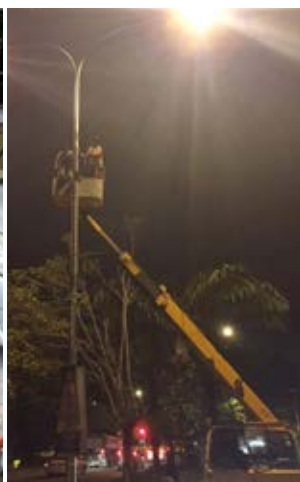
Kerja-kerja penyelenggaraan sedang dijalankan
