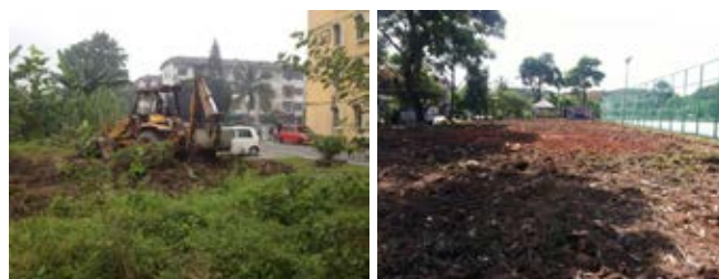
Proses pembangunan tapak Kebun Komuniti Shah Alam
